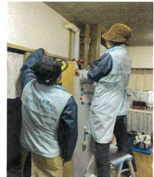
耐震留具取付の様子
