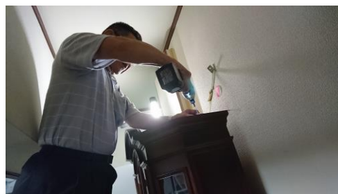
「耐震留具取付作業」
